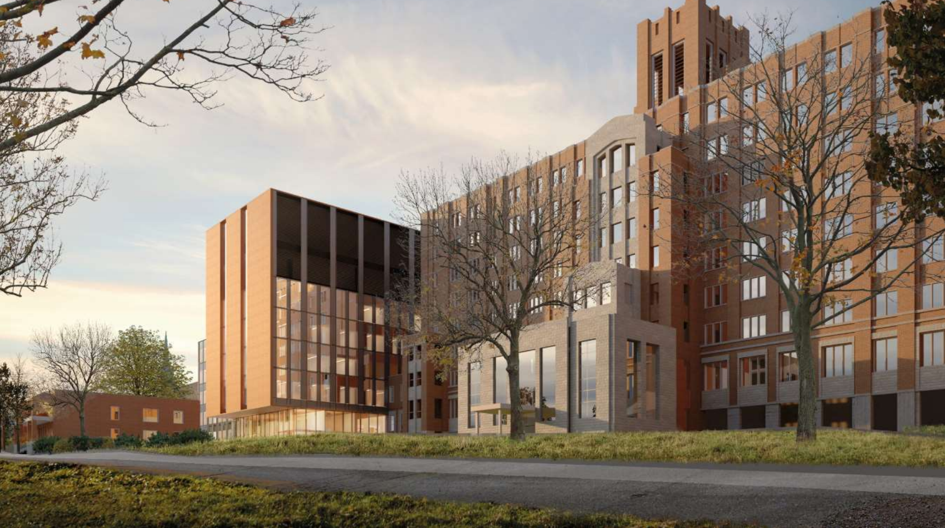
Vue du bâtiment principal existant et de l'agrandissement
